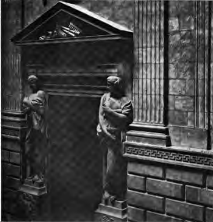
Fig. 73. — Porte dans l'escalier du Grand-Théâtre de Bordeaux (Œuvre de Louis).
